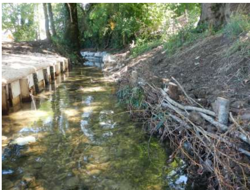
Figure 11 : illustration maintien de berge par planche et tressage de saule vivant
