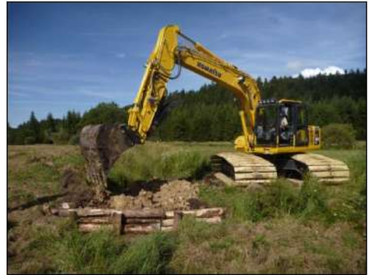
Figure 17 : Illustration de protection de jonction ancien lit / nouveau lit. A gauche mise en place de rondins d'épicéa, à droite mise en place d'un substrat argilo-marneux et de terre végétale attenant aux rondins préalablement disposées (cliché Pierre Durelet, PNR Haut Jura, restauration du Nachez, 39)
