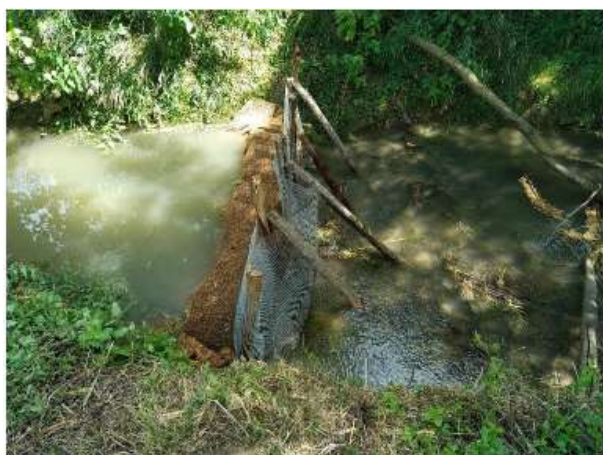
Figure 7 : Filtre à MES, botte de paille + géotextile
