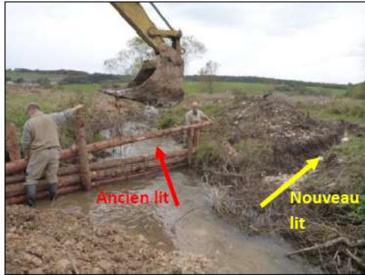
Figure 17 : Illustration de protection de jonction ancien lit / nouveau lit. A gauche mise en place de rondins d'épicéa, à droite mise en place d'un substrat argilo-marneux et de terre végétale attenant aux rondins préalablement disposées (cliché Pierre Durelet, PNR Haut Jura, restauration du Nachez, 39)
