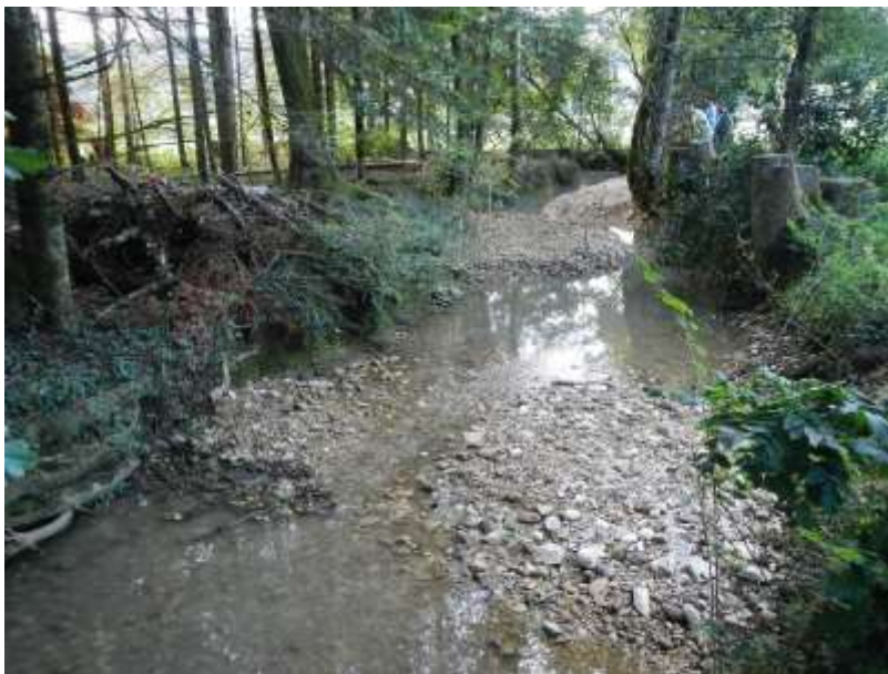
Figure 10 : Mise en œuvre de recharge sédimentaire. Mélange roulé.
